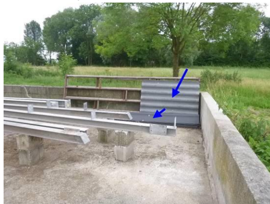
Niet asbestverdachte golfplaat en hulpstukken op mestplaat
