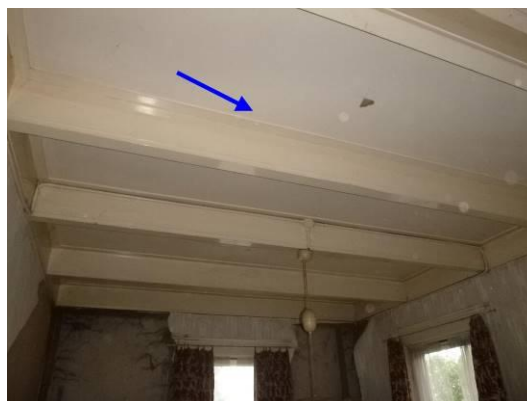
Niet asbestverdacht spanplafond tussen de balken in kamers voorhuis
