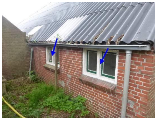
Niet asbestverdachte stopverf van kozijnen woonboerderij
