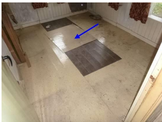
Niet asbestverdacht vinylzeil (balatum) in woonkamer voorhuis
