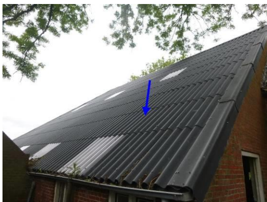
Niet asbestverdachte golfplaten en hulpstukken op dak woonboerderij
