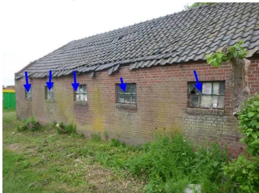
Niet asbestverdachte stopverf van kozijnen stal
