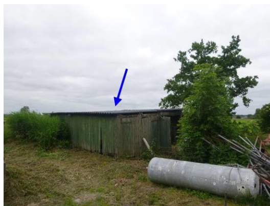
Niet asbestverdachte golfplaten op dak schuur
