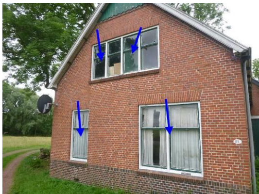
Niet asbestverdachte stopverf van kozijnen voorhuis woonboerderij
