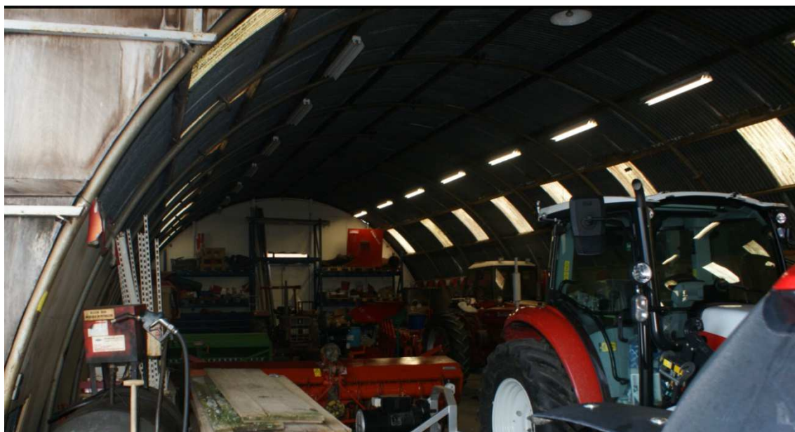
Figuur 5.2. Overzicht dakconstructie romneyloods, metalen platen zonder schuilmogelijkheden.
