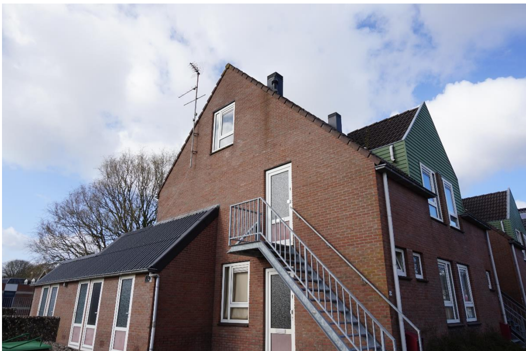
Figuur 2.3. Onderzoekslocatie ter plaatse van Schoolstraat 23-29.
