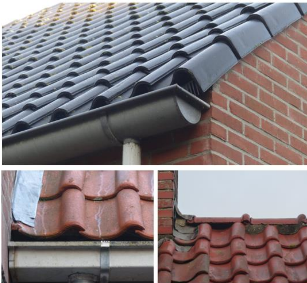
Foto 4 Boven: Vogelschroot aan de voorkant van het pand maakt het voor mussen niet mogelijk onder de pannen de broeden. Onder: aan de zijkant van het pand kunnen mussen wel onder de pannen broeden bij zowel de goot, als een gat in de nok waar metsel ontbreekt.
