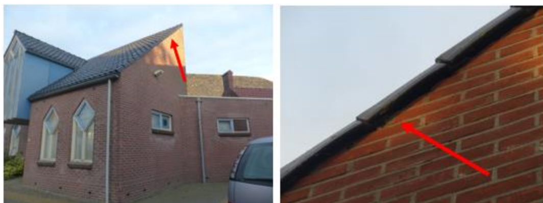
Foto 3 Geschikte invliegopeningen voor gierzwaluwen bevinden zich onder de kantpannen, waar ruime kieren zitten
