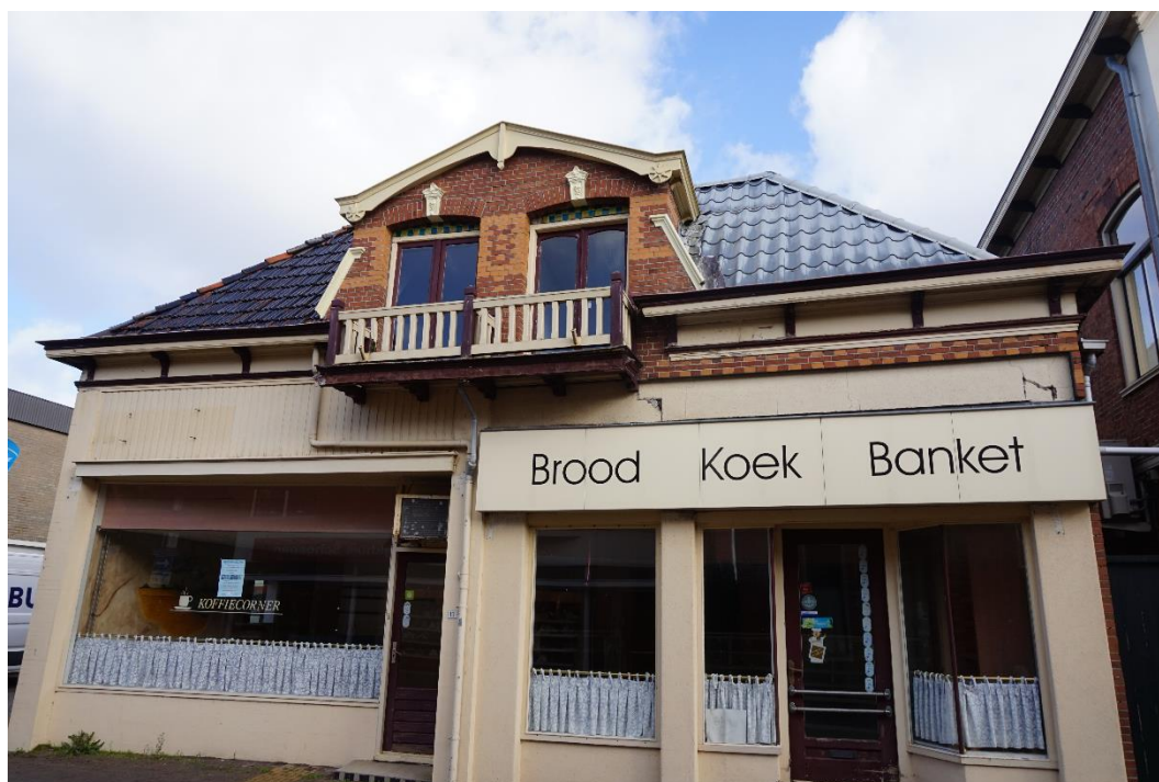
Figuur 2.7. Onderzoekslocatie ter plaatse van Hoofdstraat-Oost 13 en 15.
