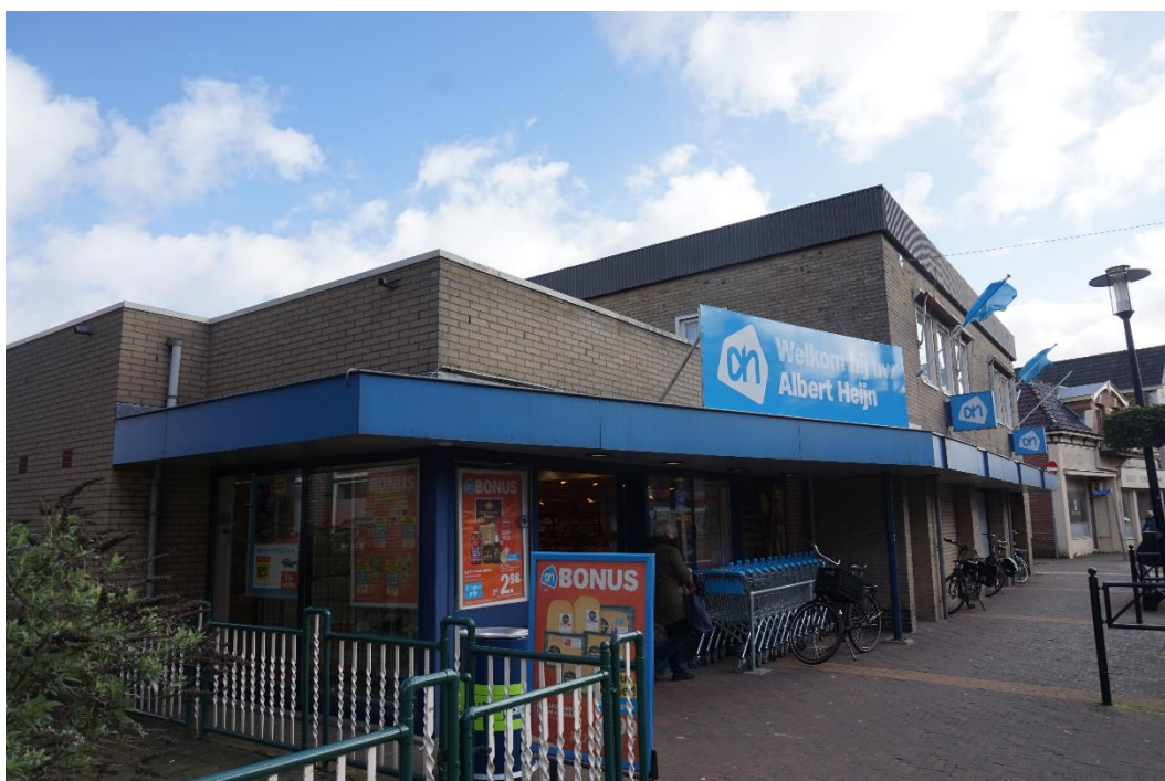
Figuur 2.5. Onderzoekslocatie ter plaatse van Hoofdstraat-Oost 9 en 11.
