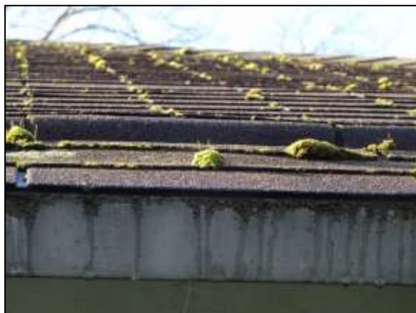
Figuur 10. Dak is strak bedekt met bitumen en er zijn geen dakgoten aanwezig.
