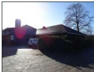
Figuur 4. Noordelijk aanzicht van de onderzoekslocatie.
