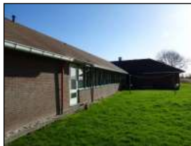
Figuur 7. Het zuidelijke aanzicht van de onderzoekslocatie.
