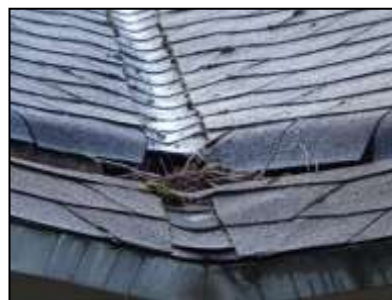
Figuur 14. Een voorbeeld van de dakgeulen boven de deuren in de bebouwing.
