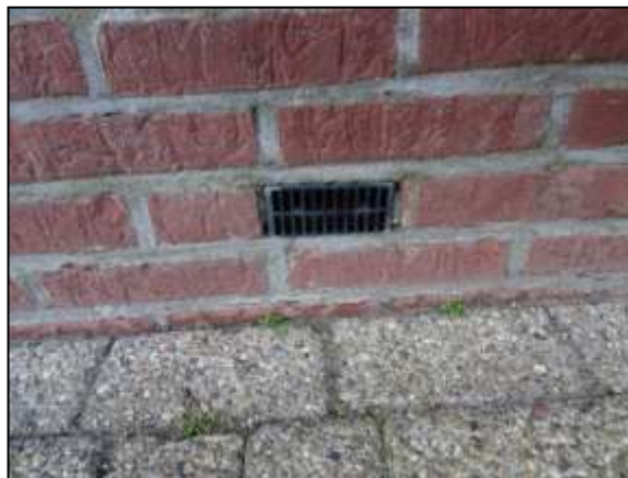
Figuur 16. Voorbeeld van een muuropening voorzien van een intact rooster.
