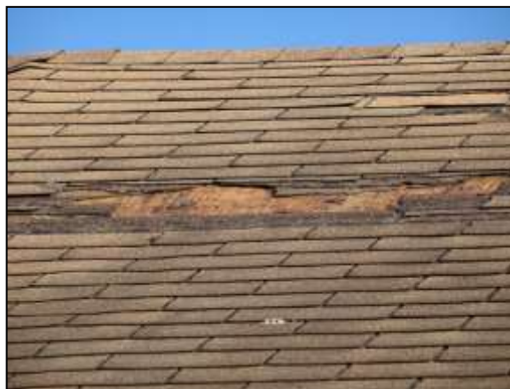
Figuur 11. Onder het bitumen ligt houtwerk, waardoor er geen ruimte is onder de dakbedekking.
