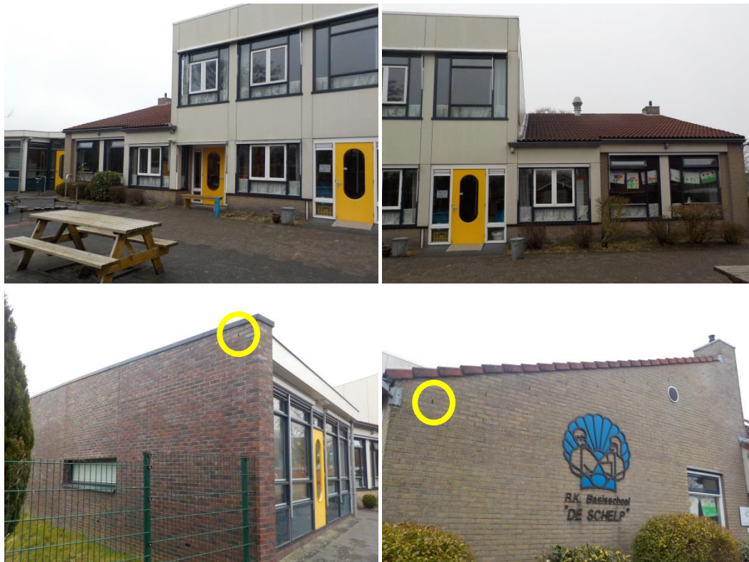
Foto 1 Impressie van de te slopen school. Boven: met trespap betimmerde middendeel. Onder: kopse kanten van de school met spouwmuur en openstootvoegen gedeelte met aluminium daklijst en een gedeelte met kantpannen die op gevel aansluiten. Bij deze kopse kanten zijn over de gehele lengte open stootvoegen aanwezig (2-3 m hoogte).
