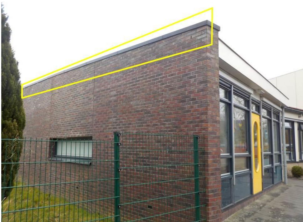
Foto 3 Geschikte invliegplekken voor vleermuizen zijn ruimten onder kantpannen en open stootvoegen.
