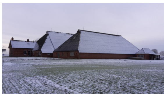
Foto 2: achterzijde pand, vanuit noordoostelijke richting
