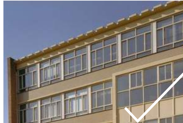
Accentueren van dakrand middel dakornament of grotere dakrand
