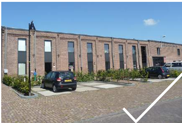
Hergebruik Stelcon-platen om industriële karakter parkeerterrein en buitenmilieu te benadrukken, gecombineerd met klinkers
