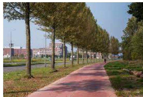
Rood fietspad conform beleid gemeente Oud-Beijerland. Het profiel van een aan te leggen fietspad moet 4 meter breed zijn
