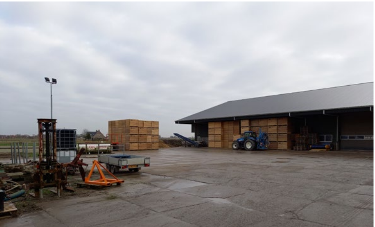
Het nieuwe deel van het erf met een groot verhardingsoppervlak en de grote loods.
