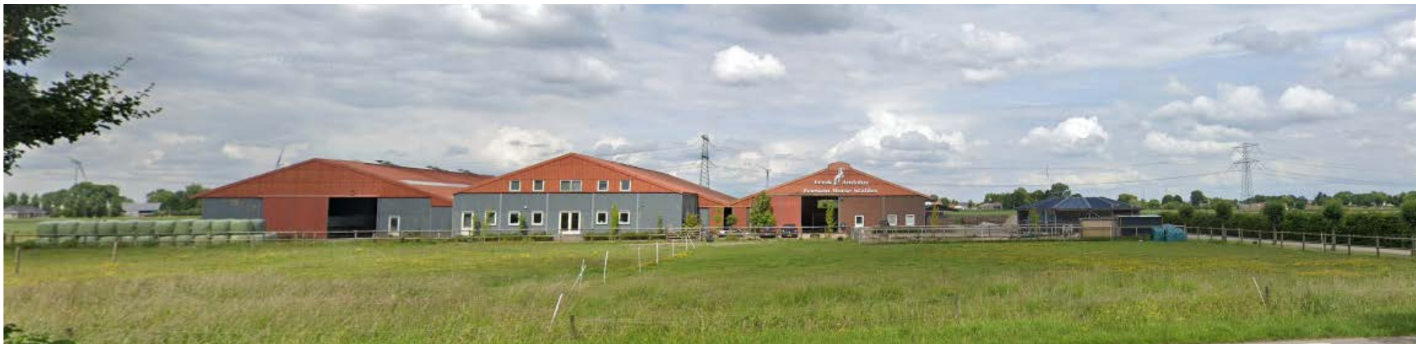
Zicht op het voorzijde erf vanaf de parallelweg langs de Provincialeweg 7d.
