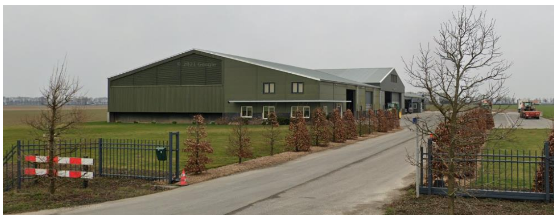
Figuur 2.5.4: Foto bestaande bedrijfsruimte (bron: Google Maps).
