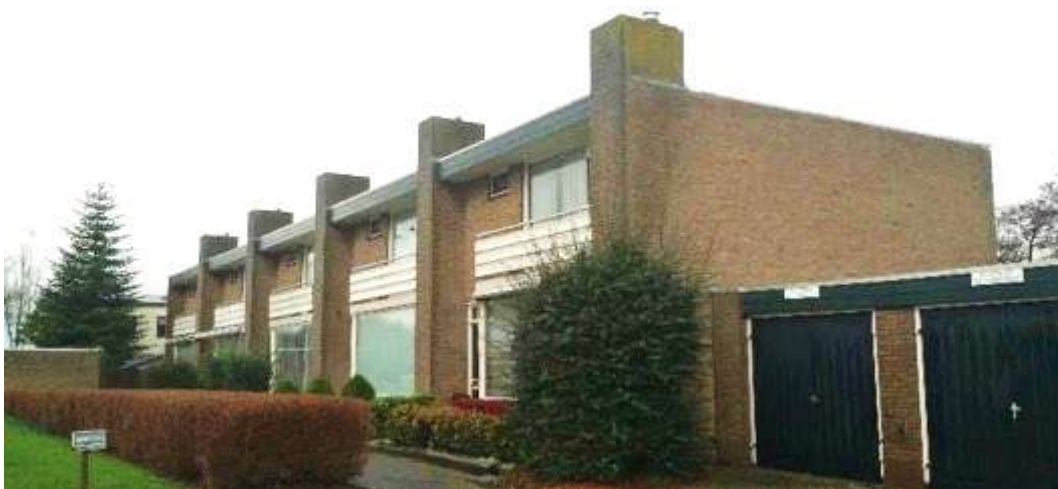
Figuur 43 De westelijke woningen aan Nieuw Weverseinde zijn afgewerkt met een bitumen plat dak en een overstek aan de voorzijde.
