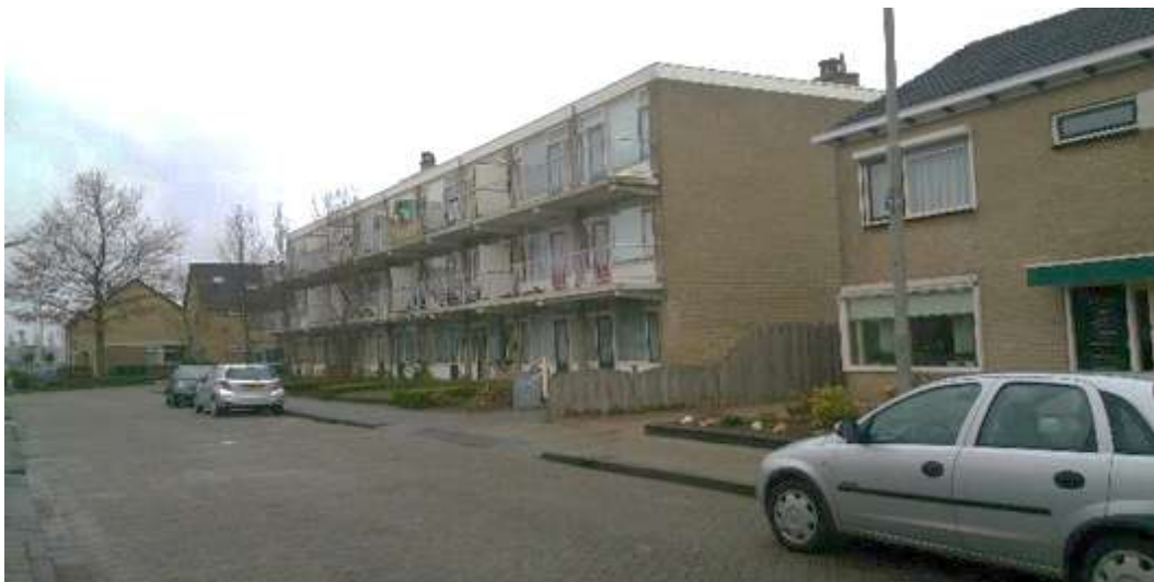
Figuur 33 De planlocatie aan de Ranonkelstraat (fase 4) betreft een appartementencomplex van 3 bouwlagen.
