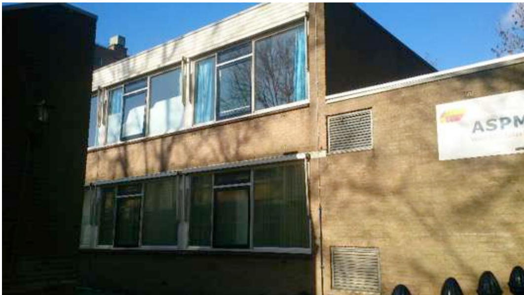
Figuur 46 Het pand is opgetrokken uit gemetselde muren met spouw en een bitumen dak. Het dak is trapsgewijs ingedeeld in hoger en lager gelegen gedeelten.
