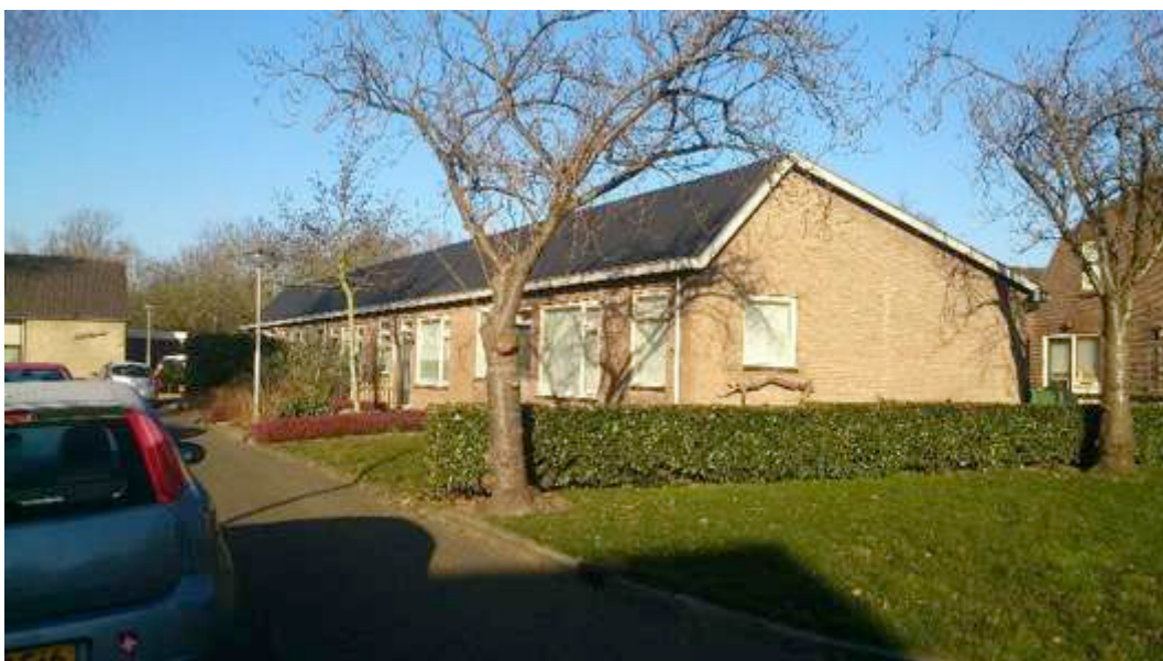
Figuur 8 De woningen zijn opgetrokken uit gemetselde muren met spouw, bitumen dak en bestaan uit 1 bouwlaag.
