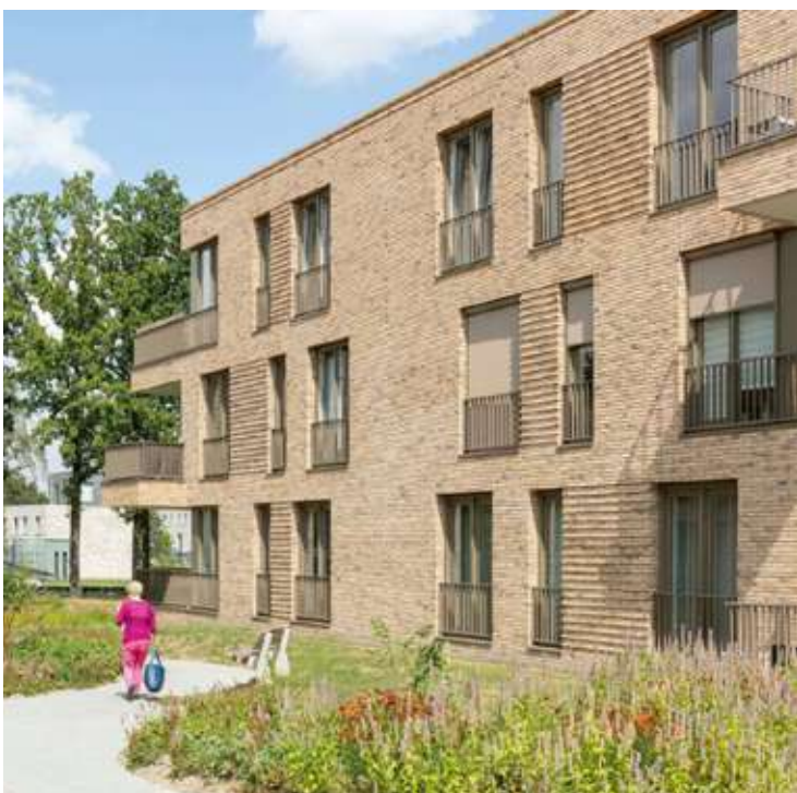
zorgvuldige detaillering metselwerk
