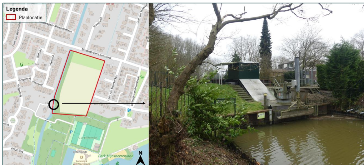
Figuur 3.1 Gemaal aan de zuidzijde van het kanaal aan de westkant van de planlocatie.
