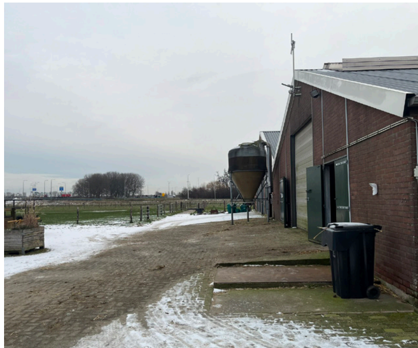
Functionele transitieruimte op het achtererf.
