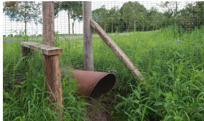
Referentiebeeld van een faunapassage (Bron: Eigen foto)
