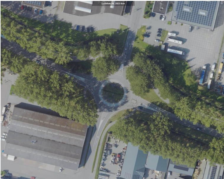
Figuur 13: Huidige inrichting rotonde Wethouder van der Veldenweg – Energieweg (Luchtfoto 2024)
