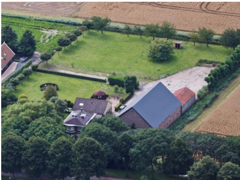
Figuur 1.5: luchtfoto Strijenseweg 137
