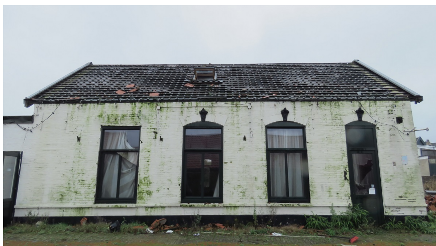
Afbeelding 11: Het dakvlak zonder dakpannen, ongeschikt voor de huismuis.
