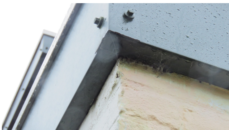
Afbeelding 13: Boeiboord, gesloten aan de onderzijde, ongeschikt voor vleermuizen.
