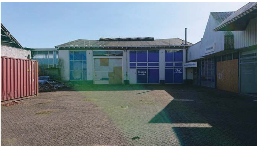
Zicht op de garage
