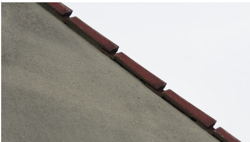
Afbeelding 8: Geveldetail woning westzijde, dakpannen sluiten zeer nauw aan op elkaar en de gevel.
