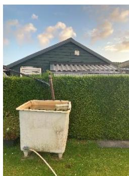
Foto 4: achterzijde bestaande schuur (richting oosten)
