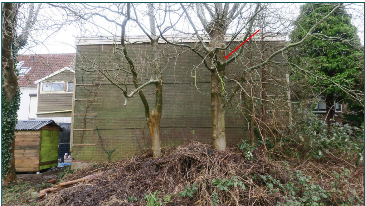
Figuur 4 De achterliggende bomen worden hoogstwaarschijnlijk gekapt, echter in de rechter boom zijn tweetal boomholtes waargenomen. Beide holtes zijn niet geschikt voor boombewonende vleermuizen.
