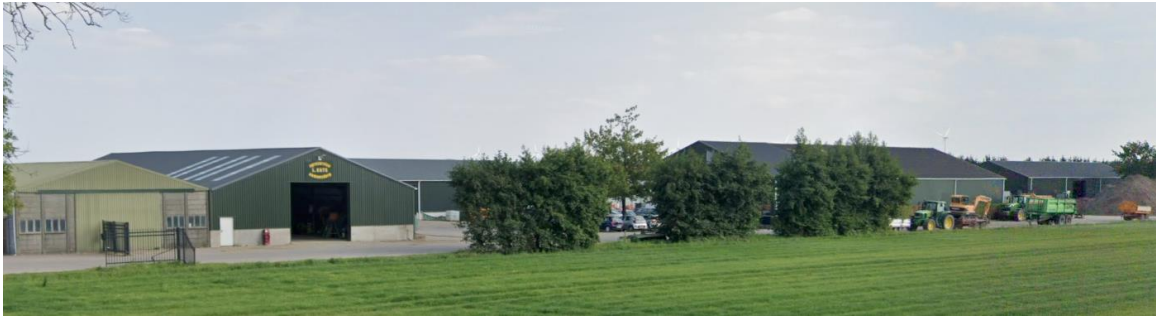
Figuur 2.1: huidige bedrijfsbebouwing
