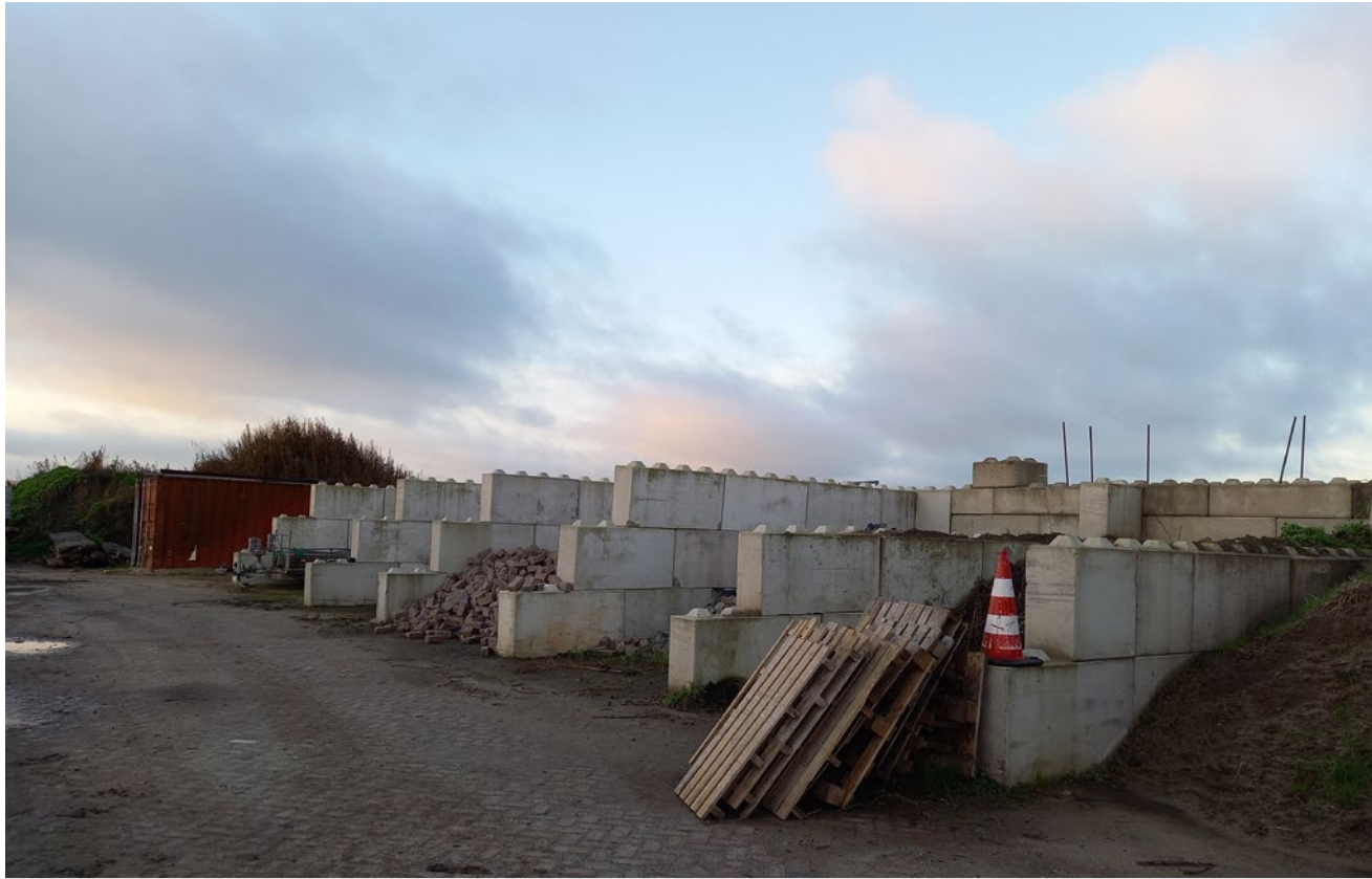
Een deel van de opslag wordt georganiseerd middels silo's van betonnen 'legoblokken'.
