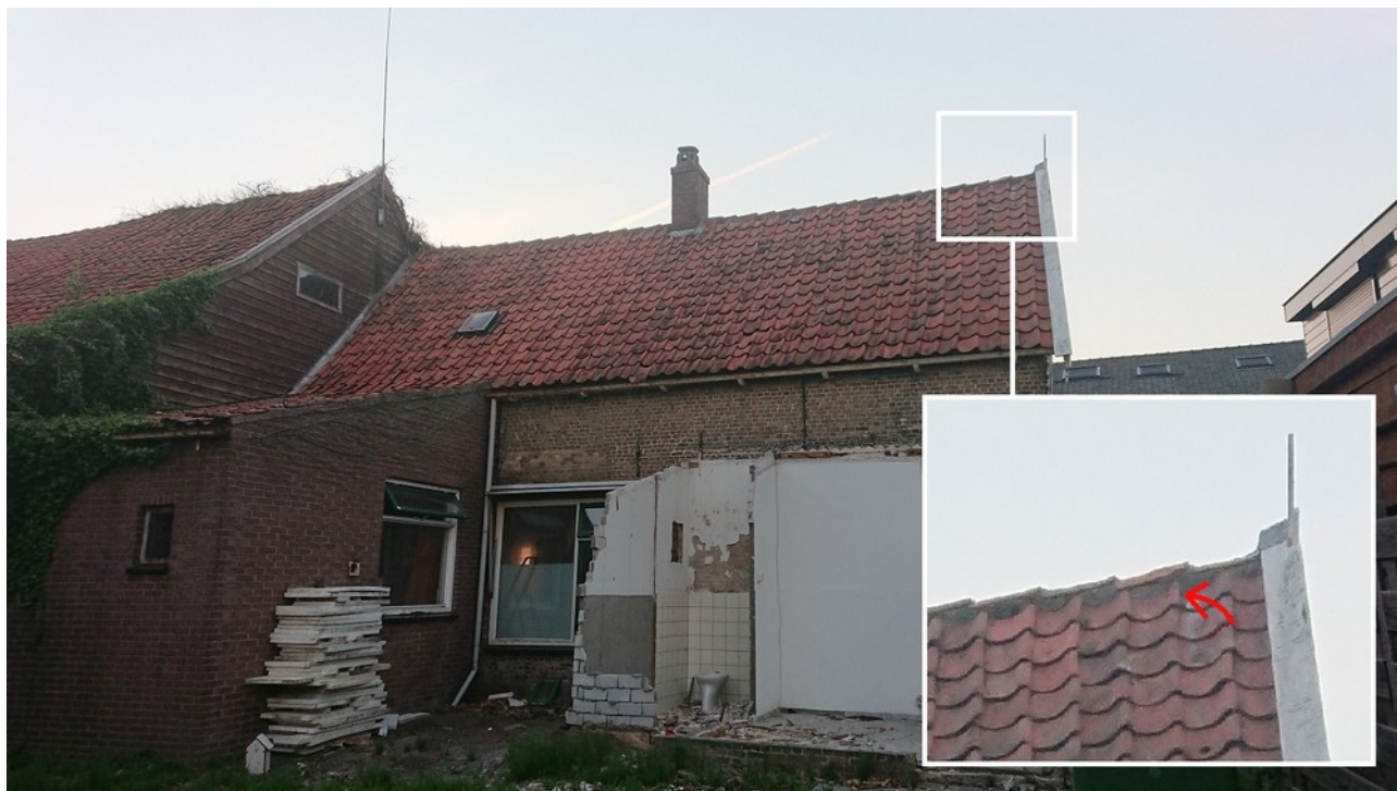
Afbeelding 5: Locatie van het gierzwaluw nest onder de dakpan aan de achterzijde van het woonhuis.
