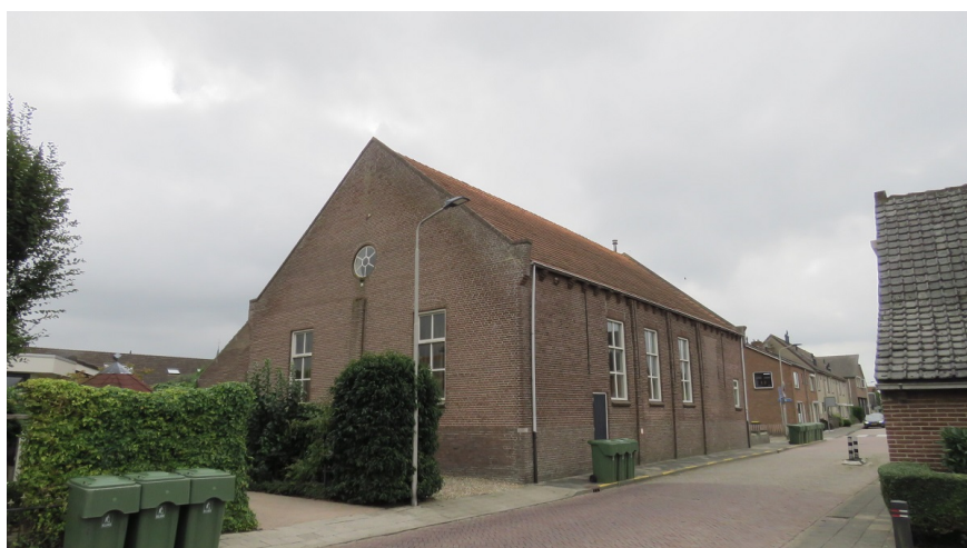
Afbeelding 3: Achterzijde van het kerkgebouw.
