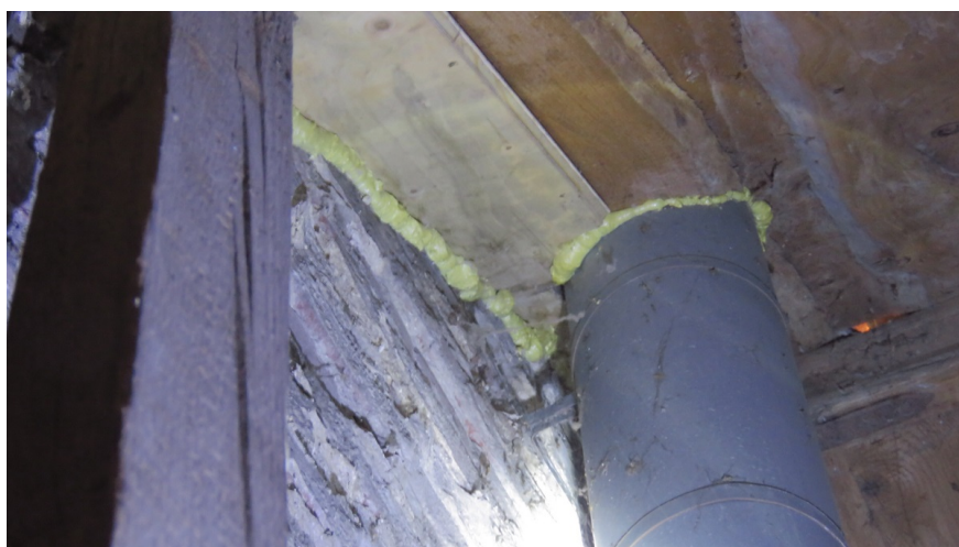
Afbeelding 11: Afgedichte kieren met purschuim in de zolderruimte.
