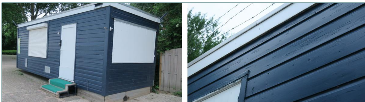
Figuur 3.3 Aanwezige stacaravan waarvan de geveldelen nauw aansluiten.
