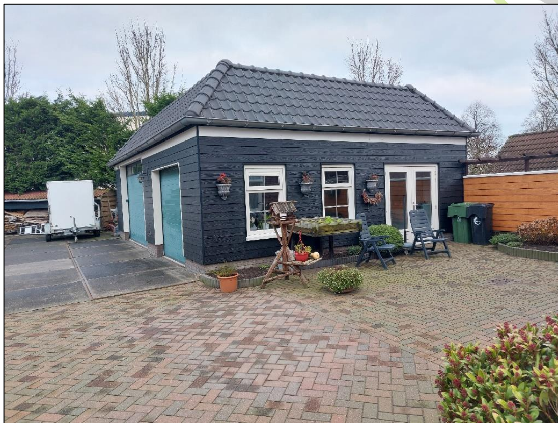
De garage met pakken dak binnen het plangebied
