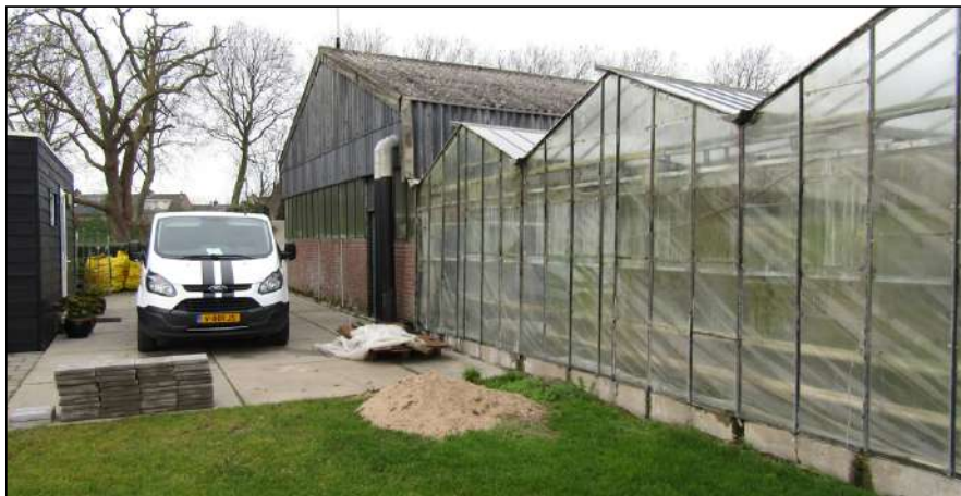
Figuur: het plangebied is ongeschikt voor vleermuizen. De enige openingen zitten tussen de beglazing en de beplating daarboven, welke beide geen houvast bieden. Daardoor kunnen vleermuizen er niet in verblijven.
