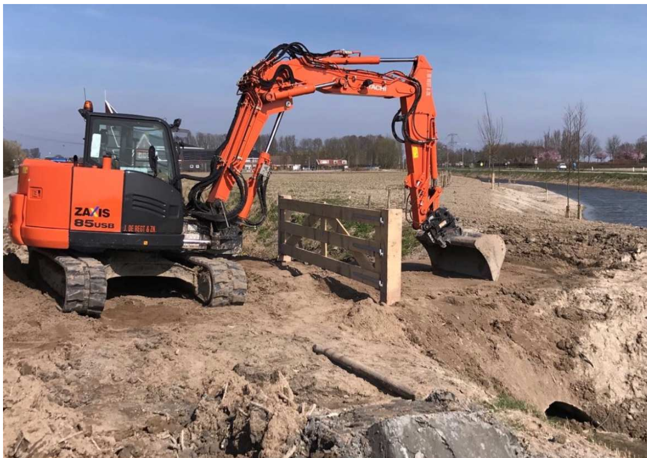
figuur 4: materieel De Regt -> aanleg groen-/blauw-/recreatieve functie in buitengebied
