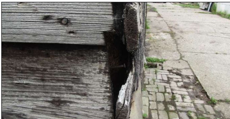
Figuur: de houten schuur op perceel 44b heeft veel openingen tussen de planken waar vleermuizen en kleine vogels, zoals huismus in kunnen vliegen. Ook de grote vos kan schuren gebruiken als overwinteringsplek.
