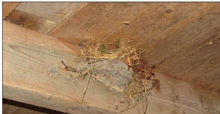
Figuur: een oud nest van een boerenwaluw, aangetroffen in de voorste schuur op het perceel bij nummer 44c en d.
