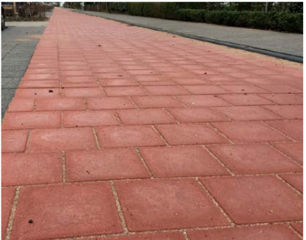
Fietspad - Betontegel rood 300x300x60mm
