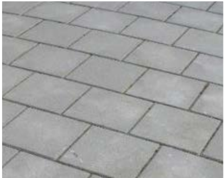
Trottoir - Betontegel met granietafwerking 300x300x60mm
