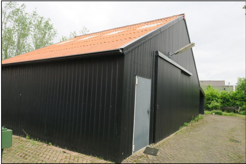
Figuur 3 De planlocatie betreft onder andere een schuur, welke is opgetrokken uit damwandplaten.
