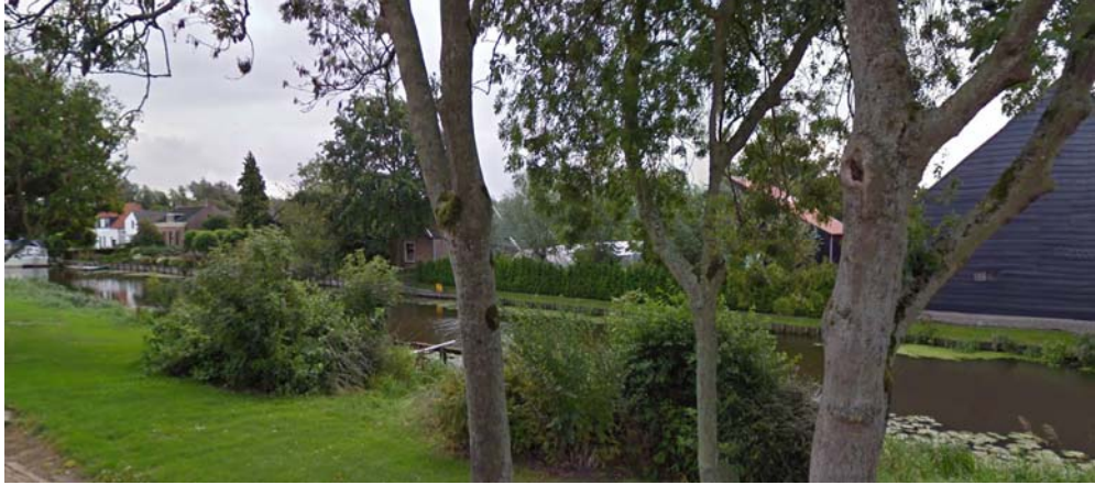
3. Bestaande grote zwarte schuur met daarnaast ondergeschikte zwarte schuur. Op voorgrond langs wat staat een coniferenhaag met daarachter knotwilgen.
