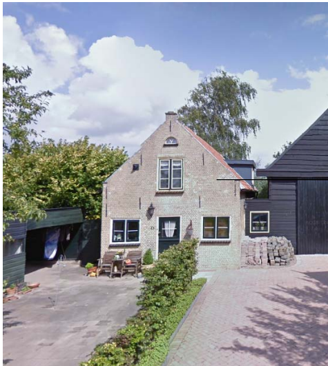
Bestaande woning met karakteristieke uitstraling wordt behouden en losgekoppeld van naastgelegen bouwwerk.
