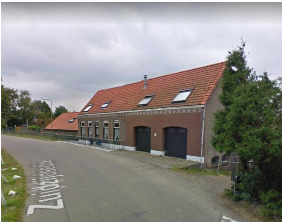
Figuur 1.3 foto bedrijfswoning en schuur
