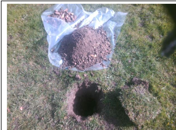
Foto 3. Asbestinspectiegat, opgegraven en gezeefd materiaal D03
