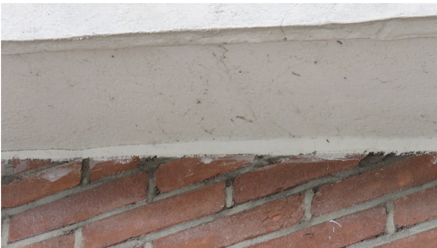
Afbeelding 10: Detail aansluiting gevel op dakoverstek.
