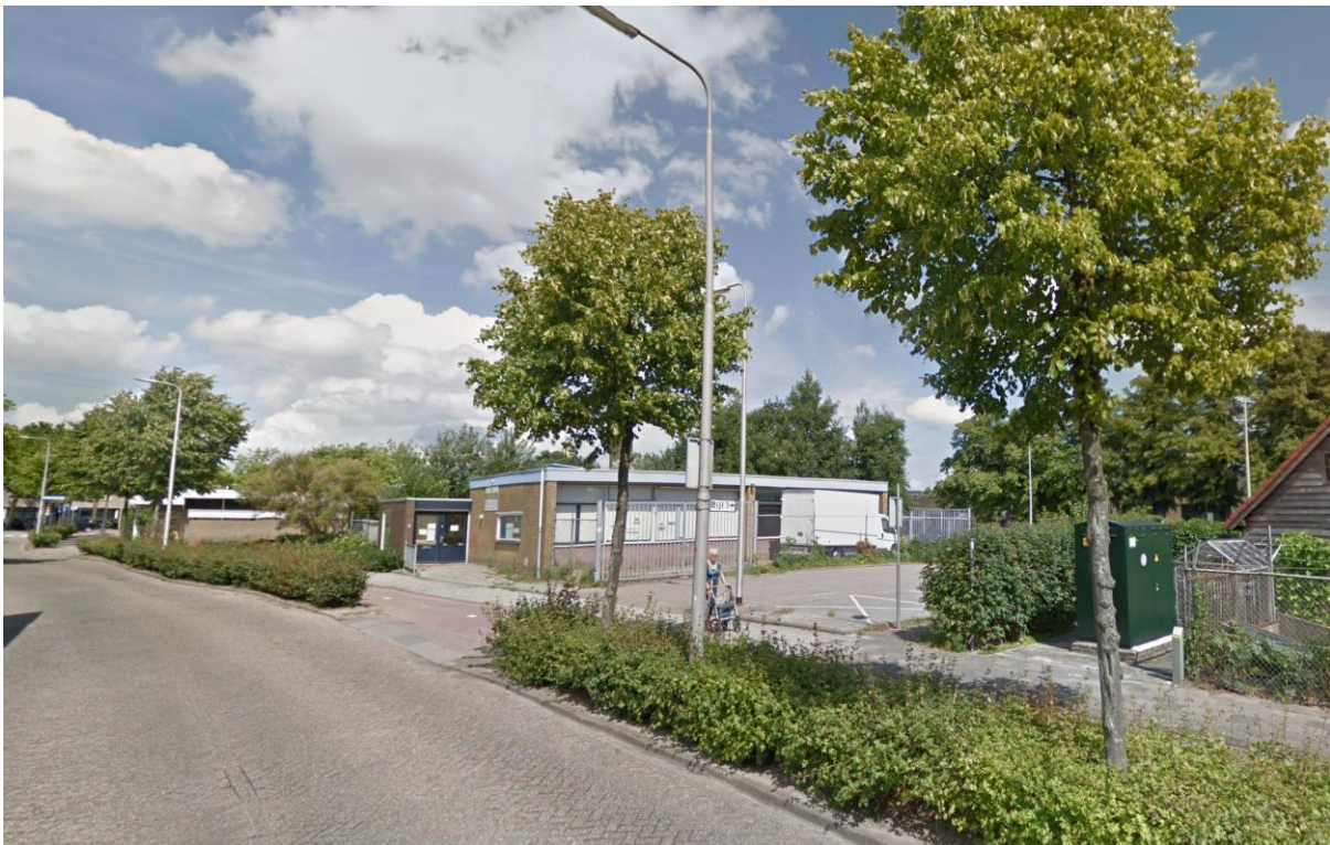
Afbeelding 2.4: bestaande situatie zuidwestzijde plangebied (bron: Google Streetview, 2017)
