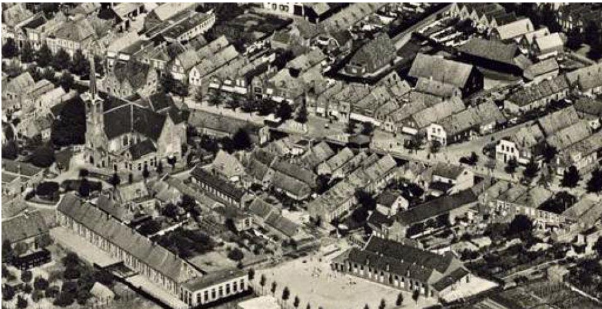
Afbeelding 2.1: zicht op de Bijlschool (rechtsonder) en de voormalige Jan Ligthartschool (linksonder) (bron: SPvE, d.d. 2017)
