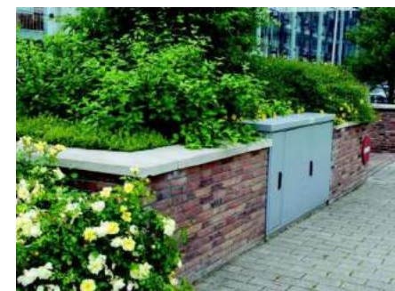
Afbeelding 40 Referentie nutskast verwerkt in tuinmuur
