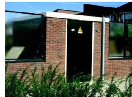
Afbeelding 39 Referentie nutskast verwerkt in tuinmuur
