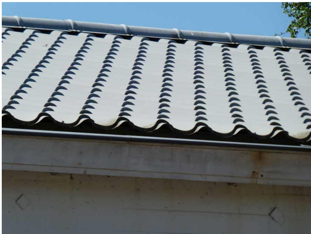
Figuur 6: Dak van loods 2
