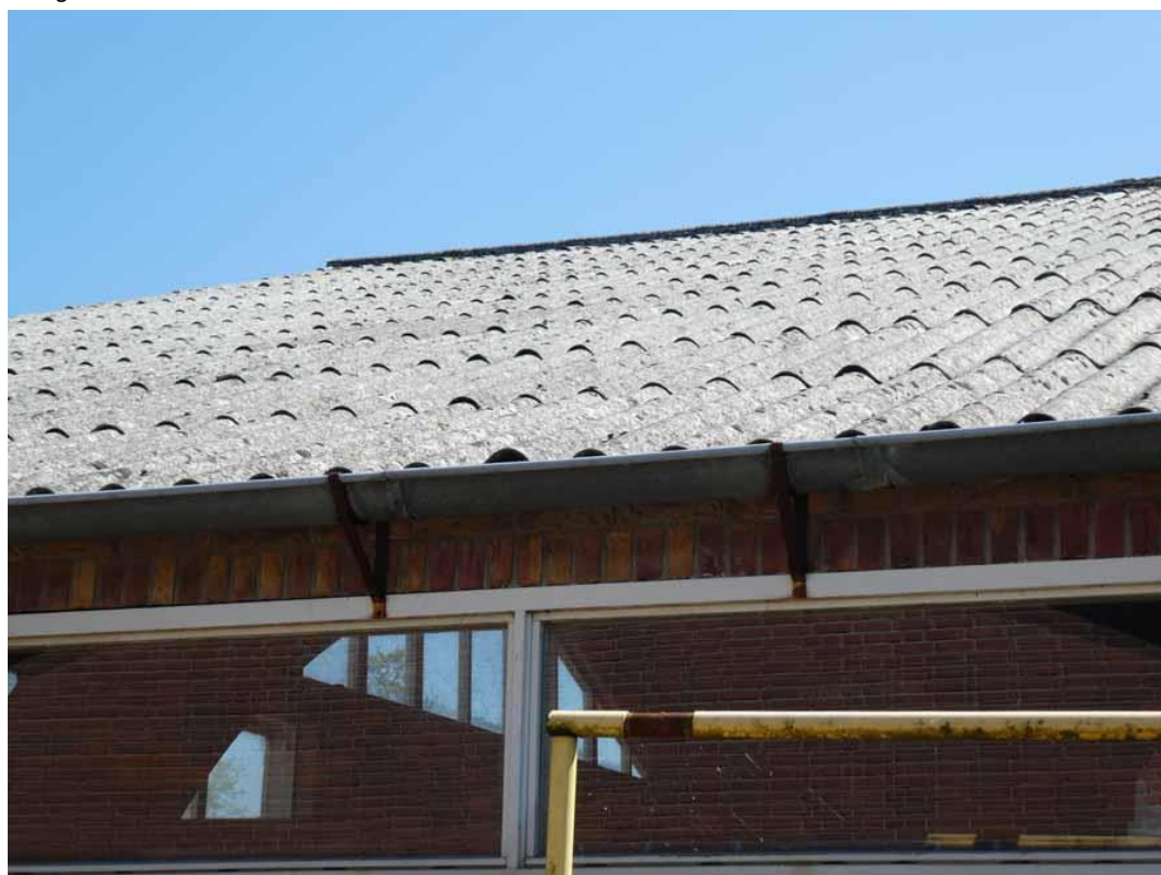
Figuur 7: Dak van loods 4
