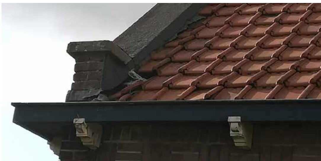
Het pannendak met enkele openingen.
