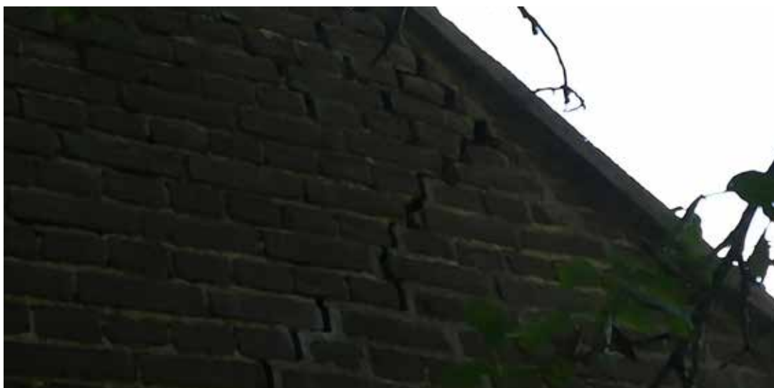
Een spleet in de buitenmuur van de te slopen woning.
