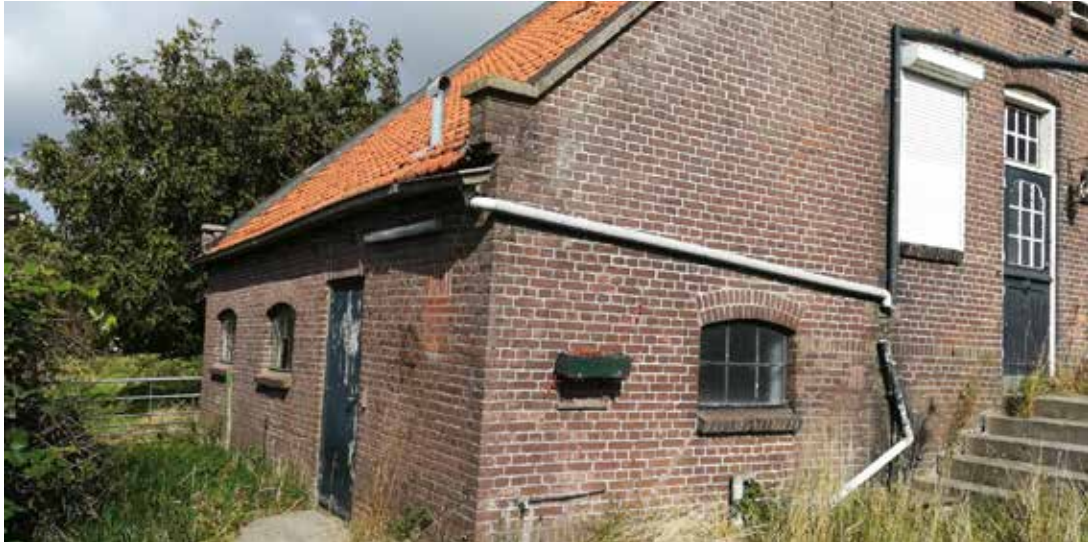
Opening boven de dakgoot, richting het dak van de woning.
