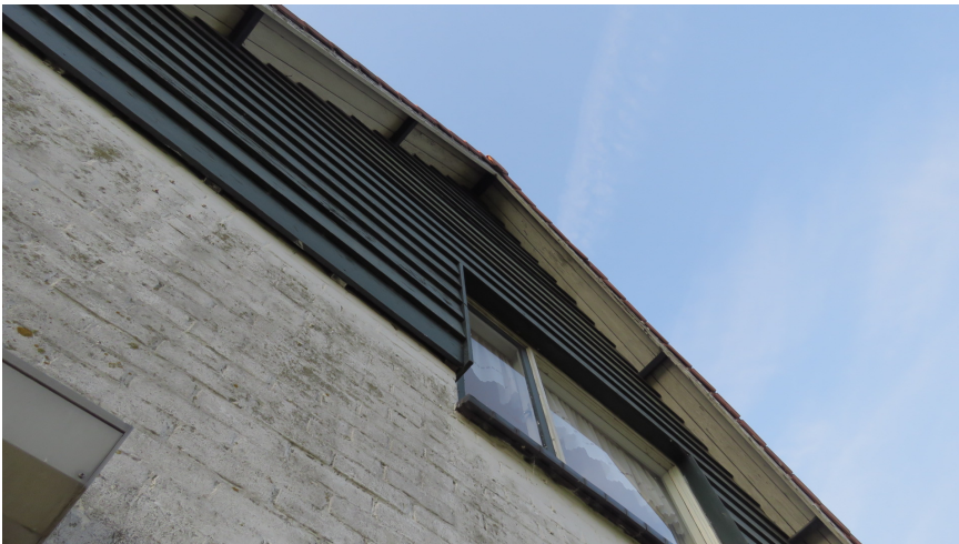
Afbeelding 8: Onder de houten gevelbekleding bestaat potentie voor vleermuisverblijfplaatsen.
