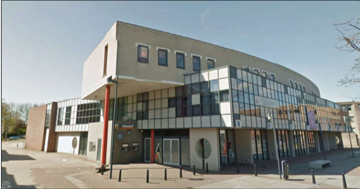
figuur 2. Foto huidige situatie (Bron: Google maps).
