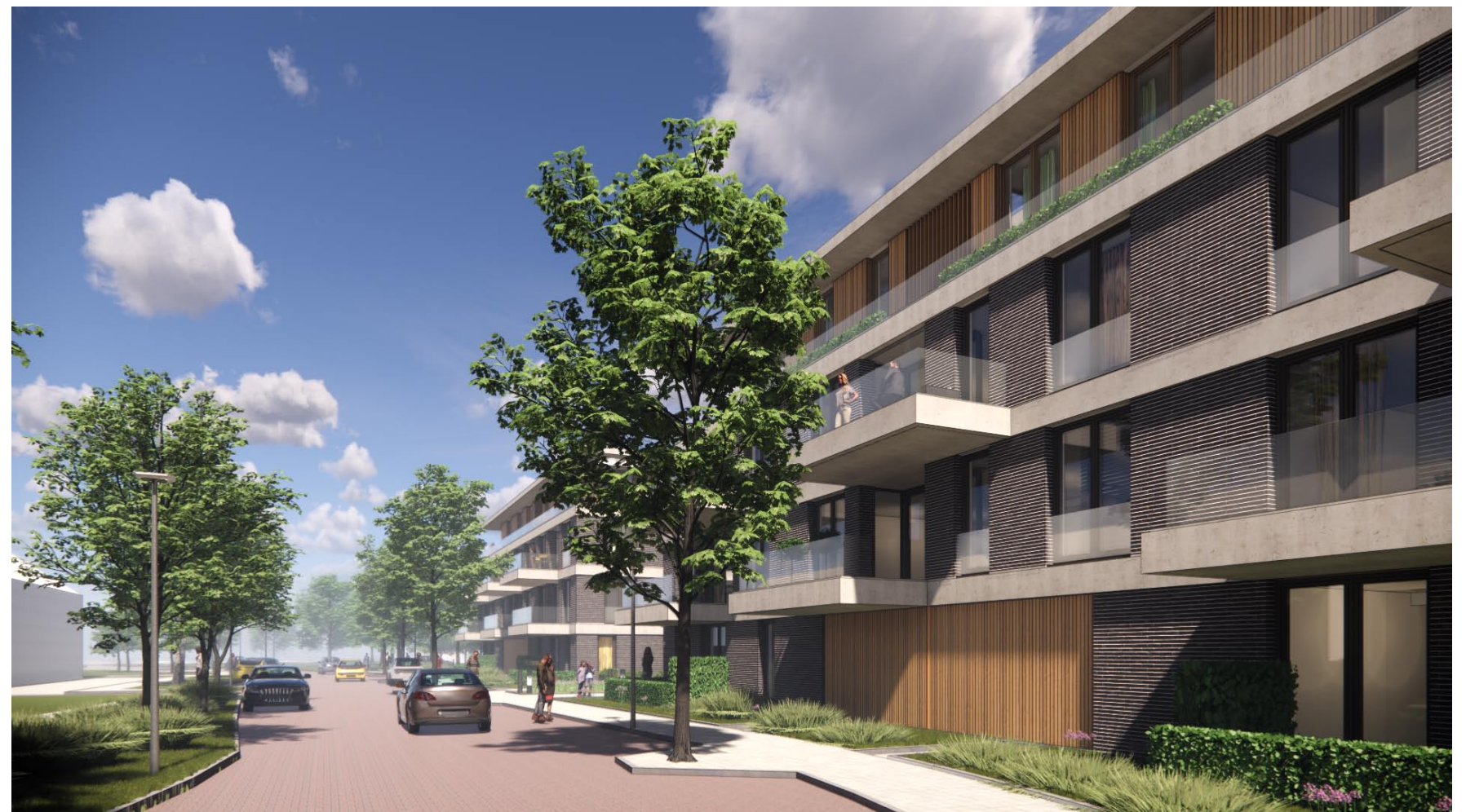
Baksteen gevels met betonbanden
