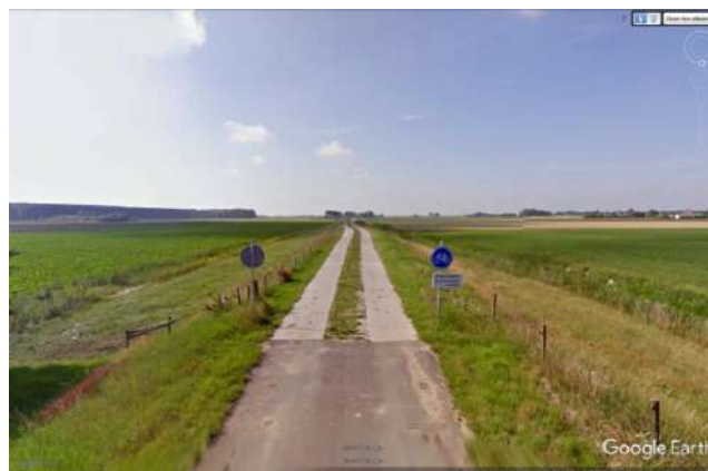
Figuur 7: betonstroken Oude Nieuwlandsedijk
