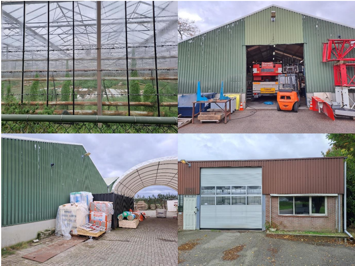
Impressie van de aanwezige bebouwing.
