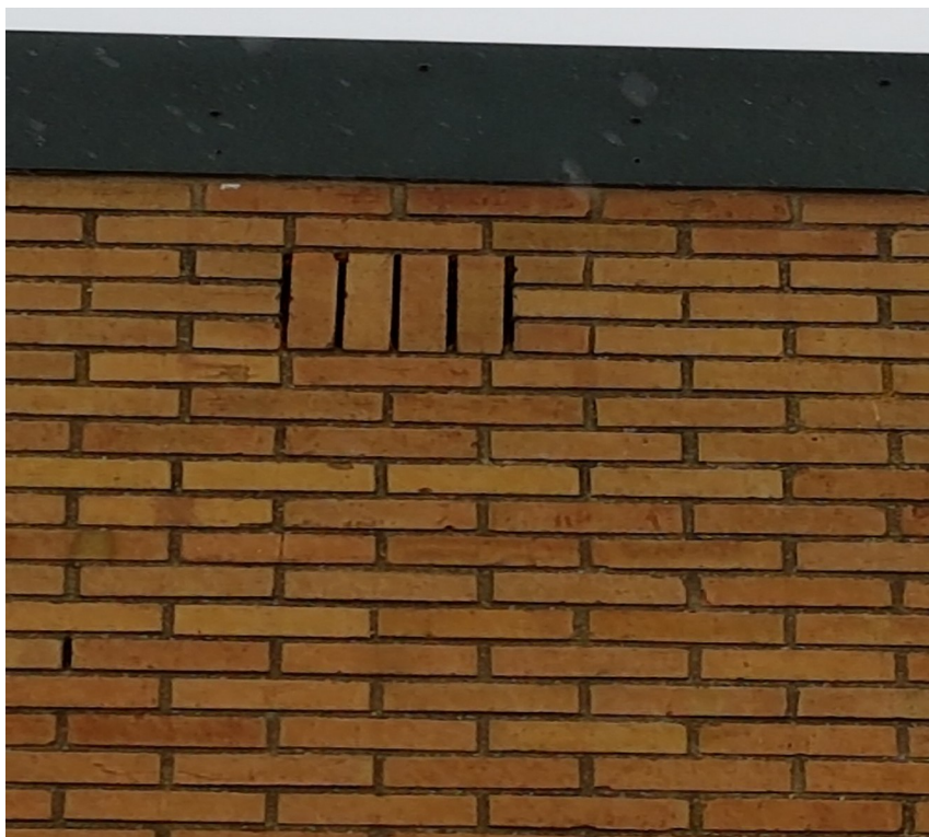
Afbeelding 9: Voor vleermuizen geschikte ventilatieopeningen in het plangebied. Foto: F.A. van Meurs | Ecoresult B.V.
