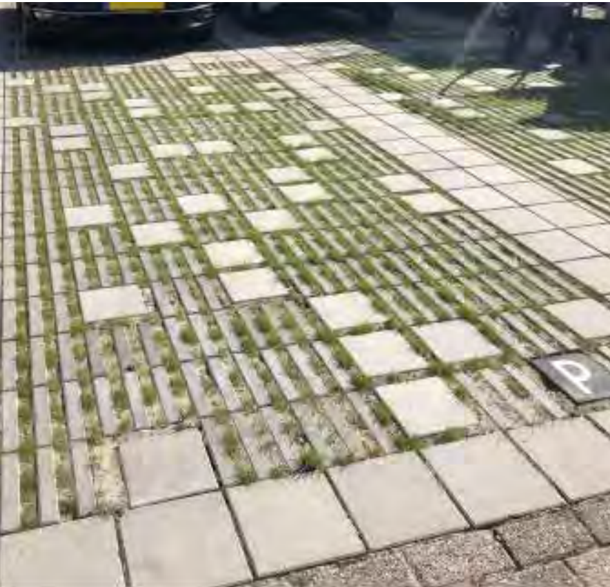
▼ voorbeeld waterdoorlatende bestrating ter plaatse van parkeervakken
